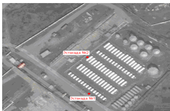
Условные обозначения: ПП-1 – эстакада №1, ПП-2 – эстакада №2. Рисунок 5 - Нефтебаза ТОО «Иволга-холдинг», г. Костанай
