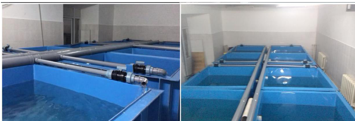
Рисунок 2 – УЗВ для выращивания клариевого сома
